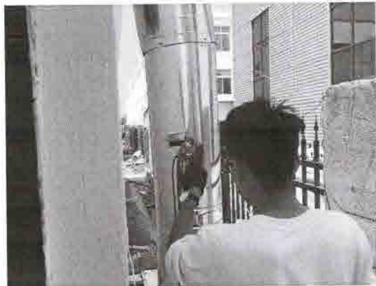
食堂油烟检测照片
